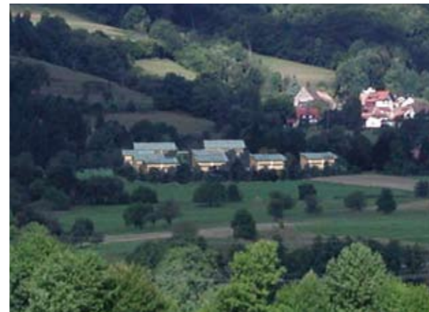
Plusenergie-Hausgruppe in Schopfheim-Raitzbach
